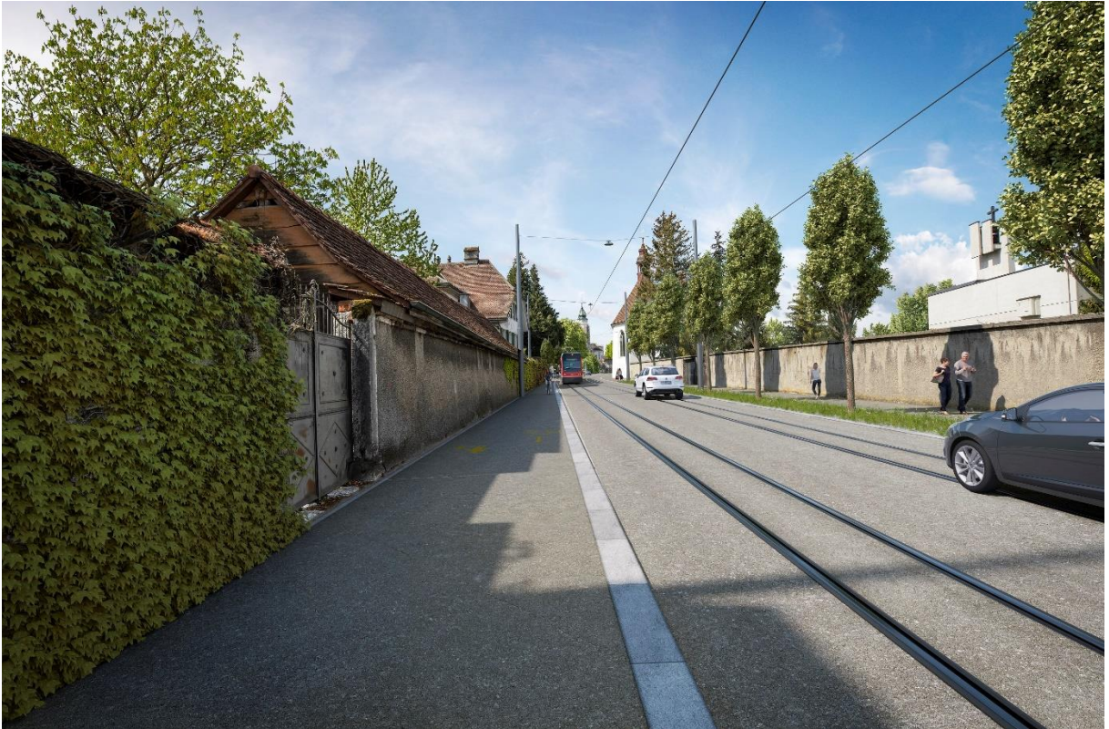
Beilage 1: Blick in Richtung Baseltor-Kreisel: Dem Fuss- und Veloverkehr steht trotz der beengten Verhältnisse auf beiden Strassenseiten genügend Platz zur Verfügung, weil sich in der Strassenmitte Bahn und motorisierter Individualverkehr ihre Spuren teilen.
